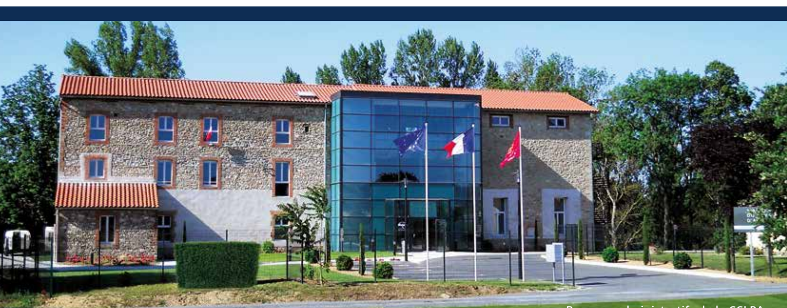
Bureaux administratifs de la CCLPA Maison du Pays - Serviès
