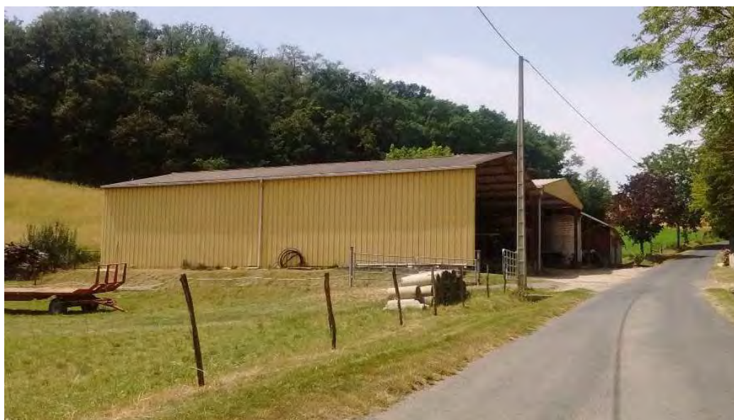
Photographie 8 : Hangar de stockage à Pratviel
