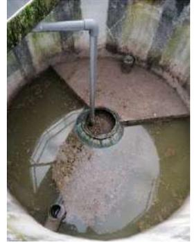
L'entretien de la station d'épuration est régulier et sérieux malgré la pénibilité de la tâche. En effet, une aération manuelle de la surface des filtres par ratissage est nécessaire hebdomadairement. Le fonctionnement reste correct tant que cet entretien est réalisé.
