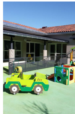
Construction de la crèche de Dourgne CC Sor et Agout
