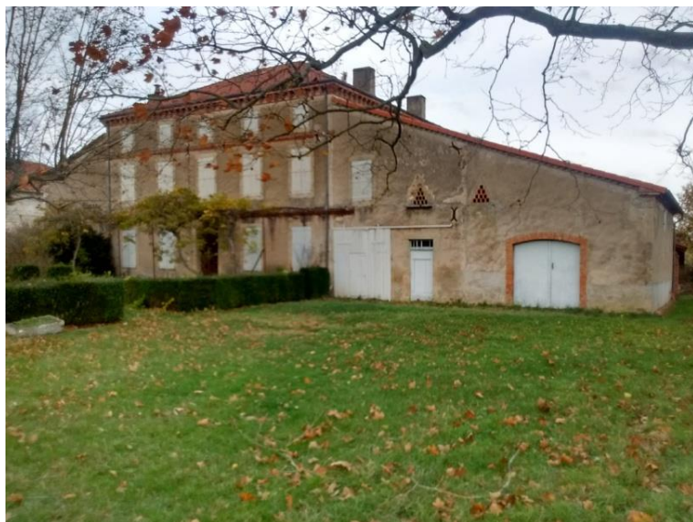
Corps de ferme à Saint-Julien-du-Puy
