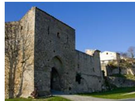
Porte de la Caussade (XIII e )
