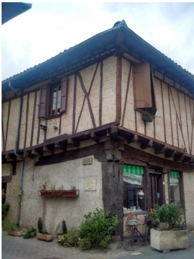
Maison à pans de bois centre bourg à Lautrec
