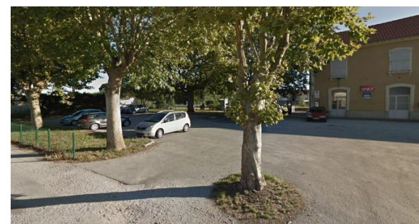
Gare de Vielmur-sur-Agout
