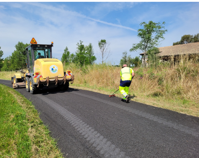
Chantier à Teyssode
