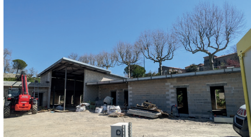
Pôle de santé intercommunal à Lautrec
